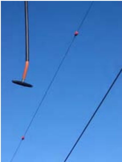
Remontée mécanique équipée de dispositif de visualisation des câbles. Photo G. Castaing
